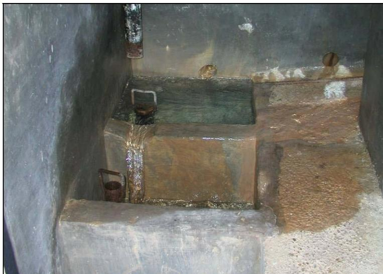
*Figura 4.24: particolare della captazione della sorgente Laghestel*
